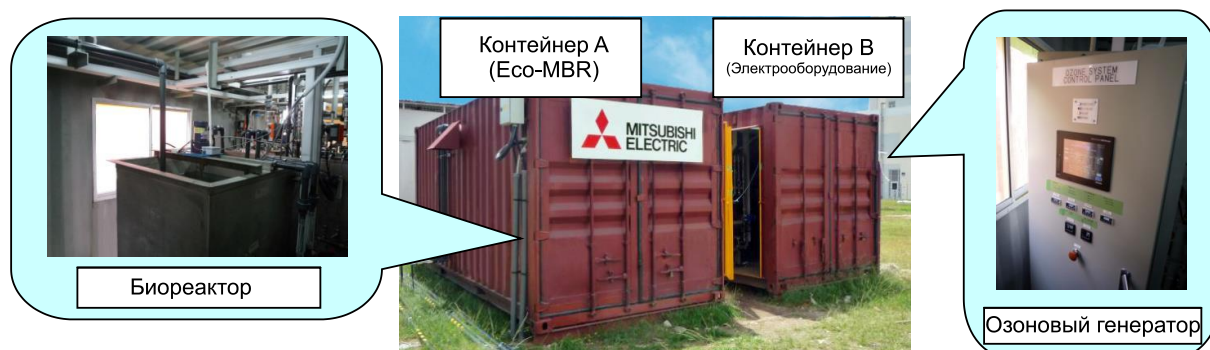
Испытание Eco-MBR в эксплуатационных условиях на водоочистой станции в Сингапуре
