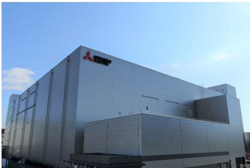
Новый цех в Kamakura Works
