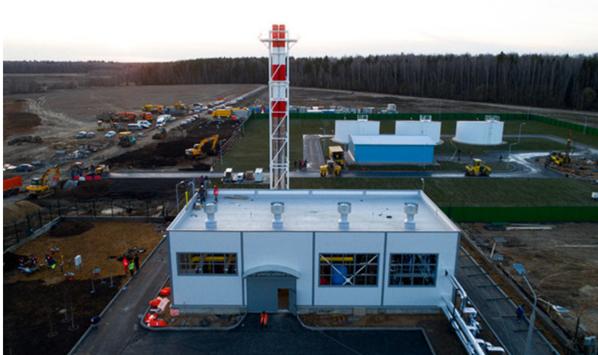
На фото: вид котельной инфекционного центра сверху
