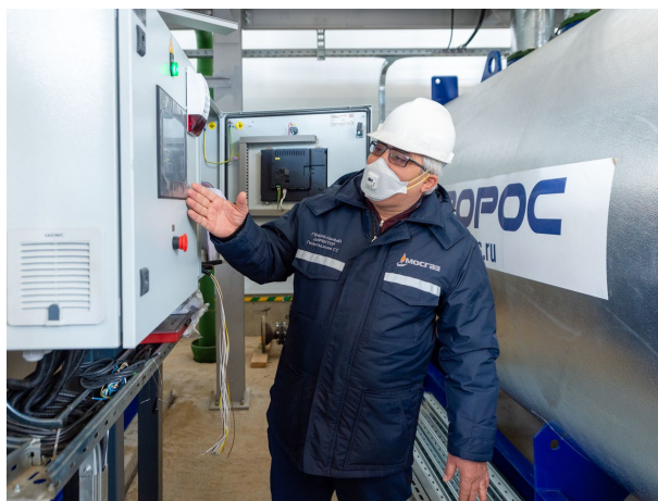
Шкаф управления котлом со встроенной панелью оператора GT2715 с цветным ЖК-дисплеем и экраном 15 дюймов
